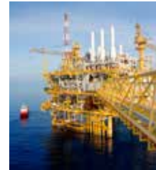
Travaux sous marins / Submarine research
